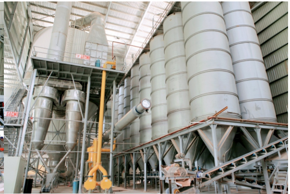
Silo bột - Silo contain
